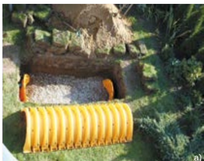
Fot. 1. Zastosowanie komór drenazowych do rozsączania wód opadowych: a) w gruncie słabo przepuszczalnym (dom jednorodzinny), b) pod powierzchnią uszczelnioną (parking supermarketu)
