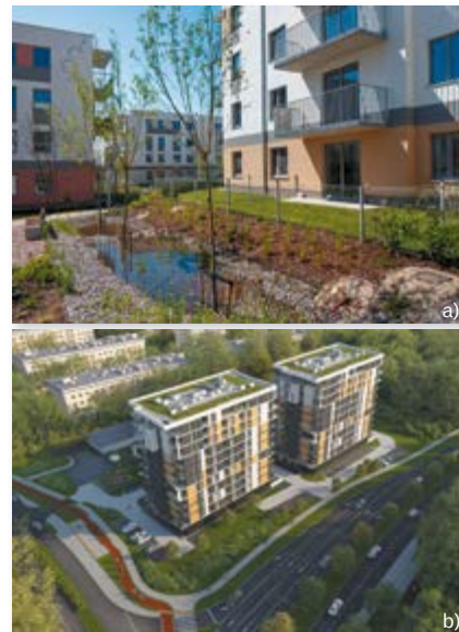
Fot. 5. Rozwiązania retencyjne na osiedlach budynków wielorodzinnych: a) ogród deszczowy na osiedlu Zielony Południk w Gdańsku (źródło: Euro Styl), b) dach zielony na osiedlu Stoneczne Tarasy w Katowicach (źródło: Mota Egil)
