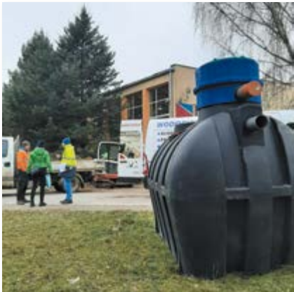
Fot. 3. Podziemny zbiornik retencyjny (pojemność: 3000 l) dla jednego z zespołów szkół w Krakowie Źródło: Klimat-Energia-Gospodarka Wodna
