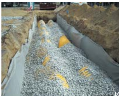
Fot. 1. Zastosowanie komór drenazowych do rozsączania wód opadowych: a) w gruncie słabo przepuszczalnym (dom jednorodzinny), b) pod powierzchnią uszczelnioną (parking supermarketu)
