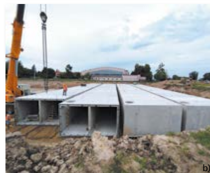
Fot. 5. Zbiorniki retencyjne prefabrykowane: a) zbiornik betonowy z możliwością uzupełnienia o dodatkowe funkcje, źródło: Ecol-Unicon, b) zbiornik żelbetowy komorowy podczas montażu, źródło: Sienkiewicz
