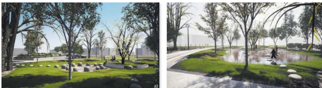
Fot. 3. Przykład zastosowania niecki infiltracyjnej w parku Rataje w Poznaniu: a) niecka w porze suchej – miejsce wypoczynku i plac zabaw, b) niecka po opadach – wodny plac zabaw
