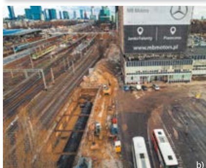
Fot. 6. Kanały retencyjne przy Dworcu Zachodnim w Warszawie: a) posadowienie kanału, b) widok kanału przy torowisku Źródło: Uponor Infra, fot. Quality Studio
