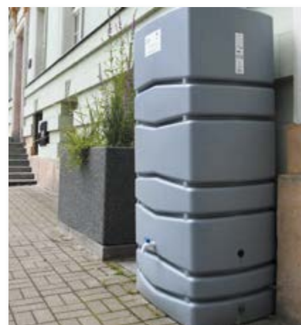
Fot. 3. Naziemne zbiorniki magazynowe o pojemności 650 l zastosowane w budynkach publicznych i mieszkalnych w ramach projektu „Zielono-niebieskie Kowary” Źródło: UM Kowary
