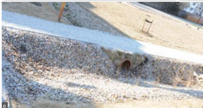
Fot. 11. Błękitno-zielona infrastruktura w gminie Leśna, wybrane przykłady: a) ogród deszczowy w pojemniku z korytkiem uspokajającym przepływ, b) połączenie zbiornika na wodę opadową z rurą spustową, c) studnia abisyńska zasilana wodą zgromadzoną w zbiorniku podziemnym, d) innowacyjna grządka typu „dziurka od klucza”, e) niecka retencyjna i ogród deszczowy (przed pierwszym okresem wegetacyjnym), f) zbiorniki na deszczówkę Fot. arch. redakcji
