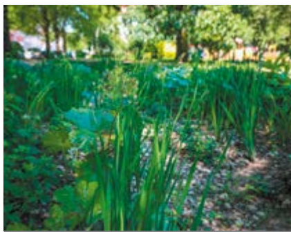
Fot. 7. Ogród deszczowy w Gdańsku, ze względu na znaczną wielkość (powierzchnia 200,86 m², pojemność 56,3 m³) nazywany „parkiem retencyjnym”
