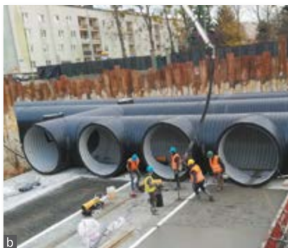
Fot. 1. Adaptacja do zmian klimatu – przykłady układów łączących rozwiązania oparte na naturze oraz rozwiązania techniczne: a) ogród deszczowy z przepustami i pochylniami dla płazów – współpraca zieleni i wody z elementami konstrukcyjnymi z betonu (źródło: ACO), b) bateria zbiorników podziemnych w Mielcu – współpraca wody opadowej i retencyjnych zbiorników z PEHD (źródło: Uponor), c) zielona ściana w Katowicach – współpraca roślin i konstrukcji ściany (arch. redakcji)
