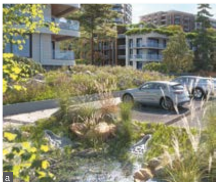
Fot. 1. Adaptacja do zmian klimatu – przykłady układów łączących rozwiązania oparte na naturze oraz rozwiązania techniczne: a) ogród deszczowy z przepustami i pochylniami dla płazów – współpraca zieleni i wody z elementami konstrukcyjnymi z betonu (źródło: ACO), b) bateria zbiorników podziemnych w Mielcu – współpraca wody opadowej i retencyjnych zbiorników z PEHD (źródło: Uponor), c) zielona ściana w Katowicach – współpraca roślin i konstrukcji ściany (arch. redakcji)
