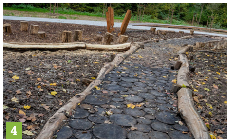
Rys. 15. Różne rodzaje nawierzchni przepuszczalnych wykorzystanych w Leśnej: (1) nawierzchnia z kostek betonowych z przerwami dylatacyjnymi; (2) nawierzchnia z płyt betonowych z przerwami; (3) nawierzchnia mineralna przepuszczająca wodę; (4) nawierzchnia z elementów drewnianych. Fot. M. Dragan
