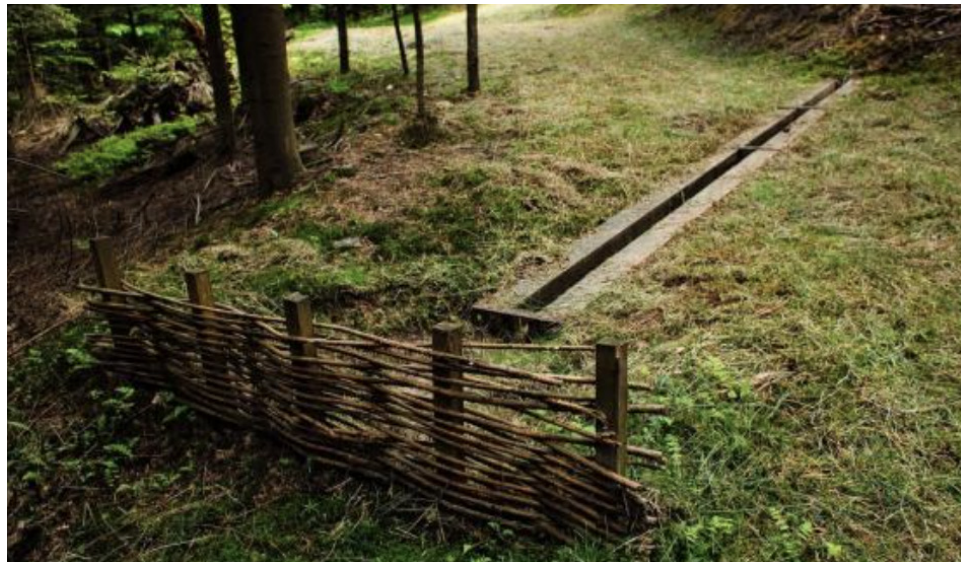
Rys. 5. Wodospust i rozpraszacz – płotek z wikliny spowalniający spływ wody i zatrzymujący osady na drodze leśnej. Zdjęcie pochodzi ze strony: ckps.lasy.gov.pl/aktualnosci/-/asset_publisher/HTXX9aadlRBB/content/jak-zebrac-wode-z-drogi (dostęp 1.03.2024 r.)
