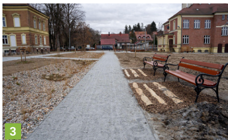
Rys. 15. Różne rodzaje nawierzchni przepuszczalnych wykorzystanych w Leśnej: (1) nawierzchnia z kostek betonowych z przerwami dylatacyjnymi; (2) nawierzchnia z płyt betonowych z przerwami; (3) nawierzchnia mineralna przepuszczająca wodę; (4) nawierzchnia z elementów drewnianych. Fot. M. Dragan
